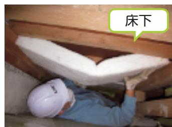
床下点検口などから床下に入り、断熱材を施工する。
