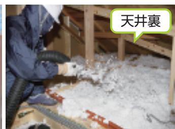
天井点検口などから天井裏に入り断熱材を施工する。
